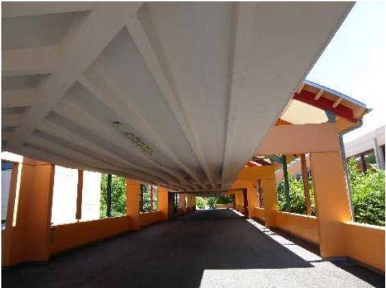
Coursive centrale, détail dalle nervurée
